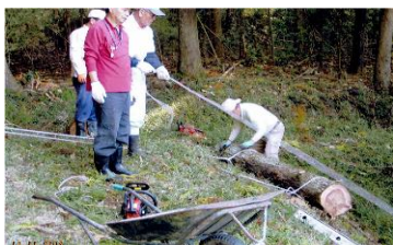
倒木の撤去作業
